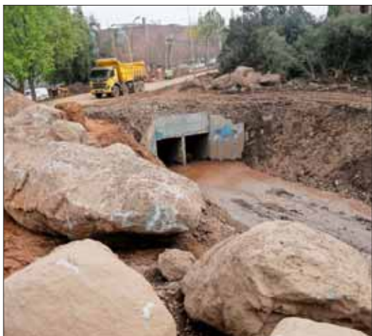
La "zona cero". La obstrucción de estos ductos, en Álvaro del Portillo con avenida La Plaza, originó el desastre que el jueves dañó dos mil casas en Las Condes.
