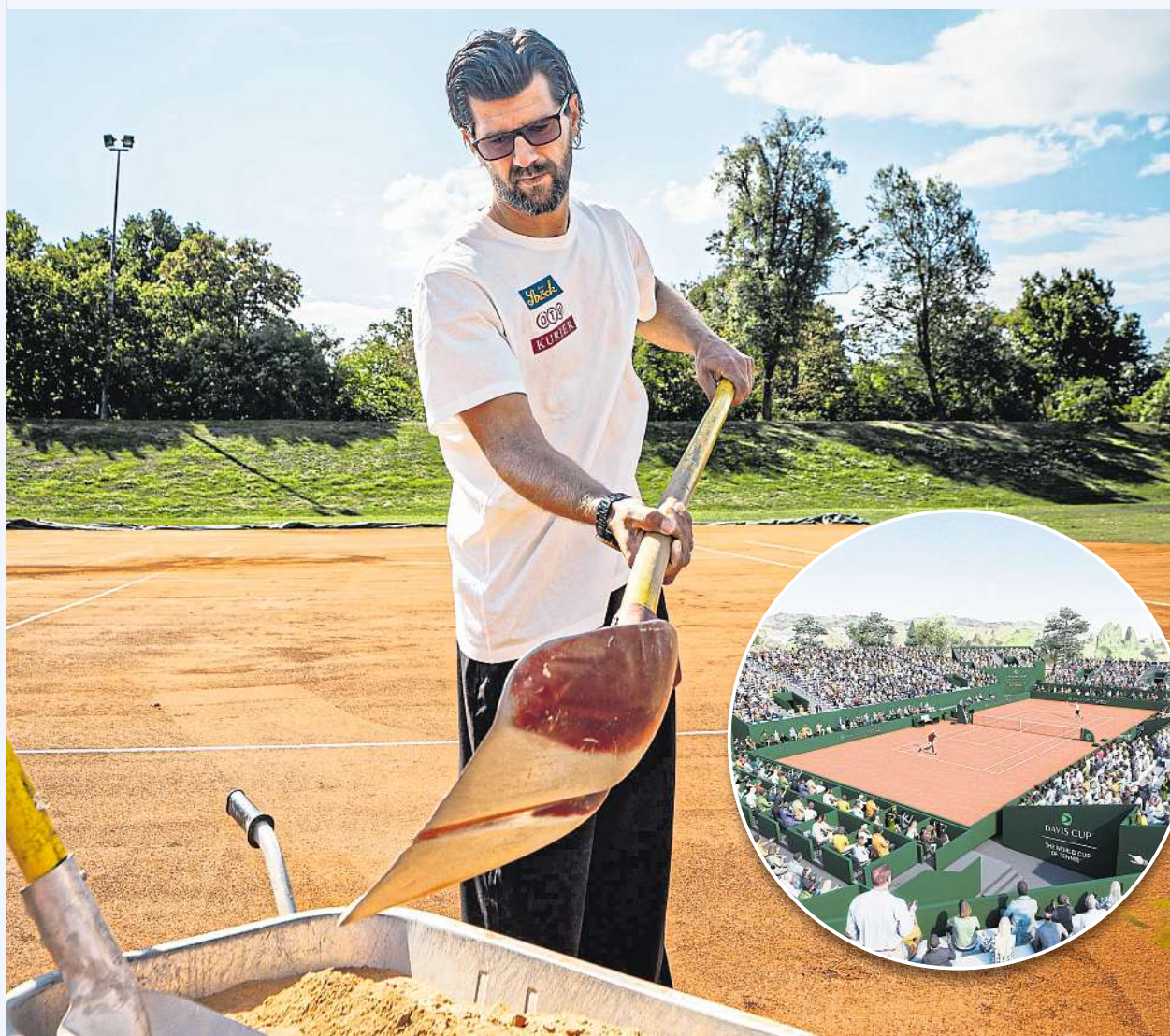
Jürgen Melzer auf der fast fertigen Spielfläche, bis 9. September wird das Stadion errichtet. GEPIC PICTURES/KEVIN HACKNER, © NONSTANDARD
